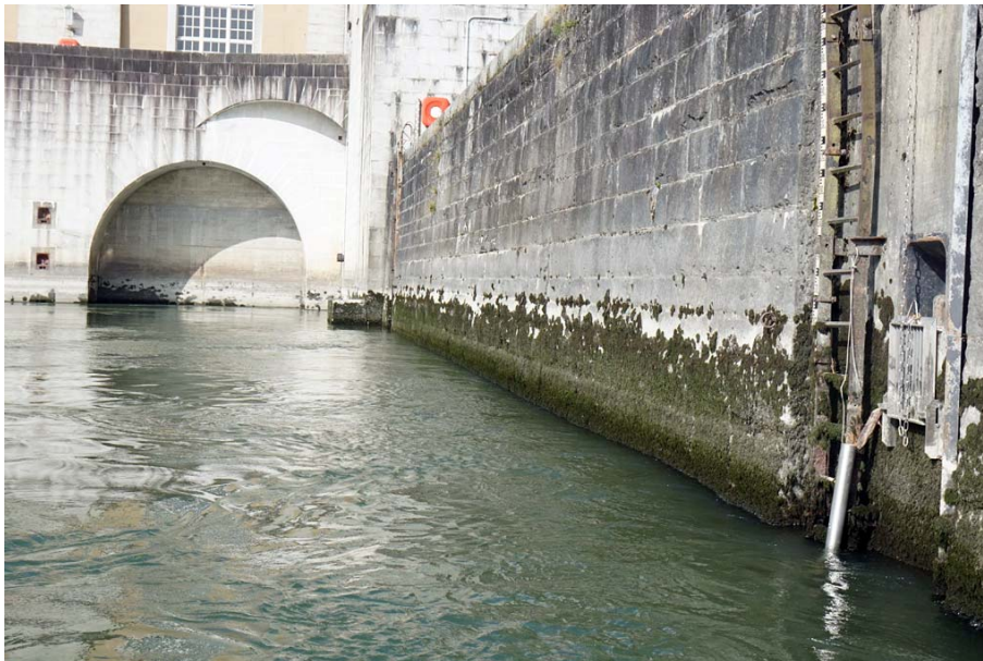
Abbildung 4: Logger Nr. 1 (Rohr rechts im Vordergrund), unterhalb der Turbinen („Saugschlauch“) KW Jochenstein.
